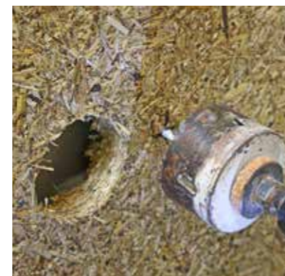
Einschneiden der Öffnung mit Bohrkronen
