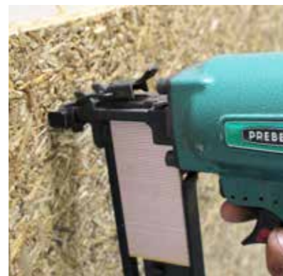
Befestigen mit Breitrückklammern mit Setzgerät
