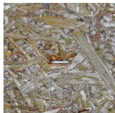
Oberflächenbündig gesetzte Klammer
