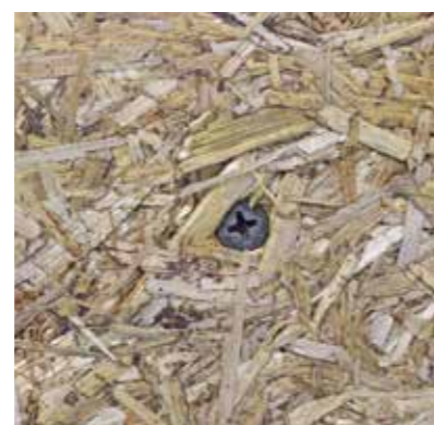
Oberflächenbündig gesetzte Schraube
