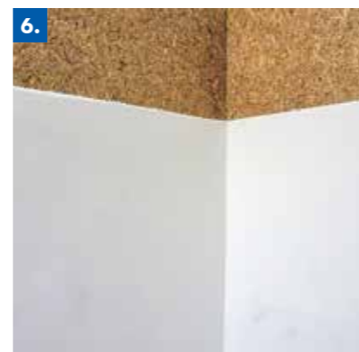
Oberfläche mit Kalkglätte abgespachtelt
