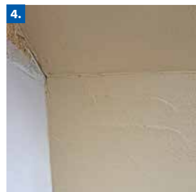
Putz auftragen (3 bis 4 mm bzw. 8 bis 10 mm) und abziehen
