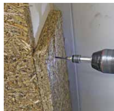
Befestigen mit Flachkopfschrauben
