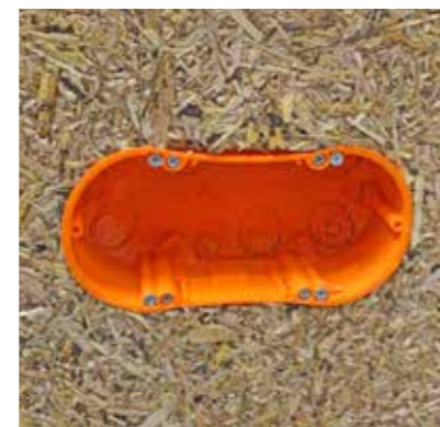
Passgenau eingesetzte Hohlraumdose
