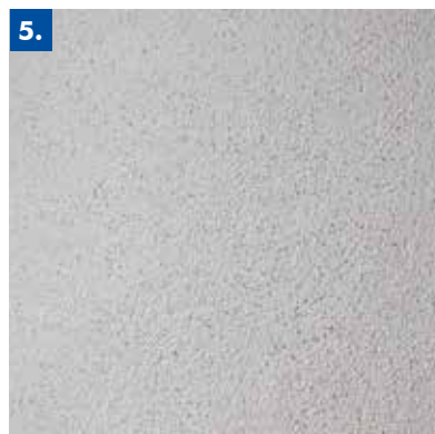
5. Oberfläche fertig gefilzt
