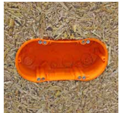
Passgenau eingesetzte Hohlraumdose
