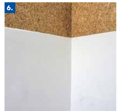
6. Oberfläche mit Kalkglätte abspachtelt
