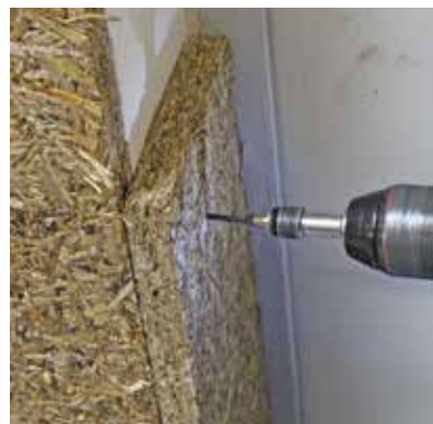
Befestigen mit Flachkopfschrauben
