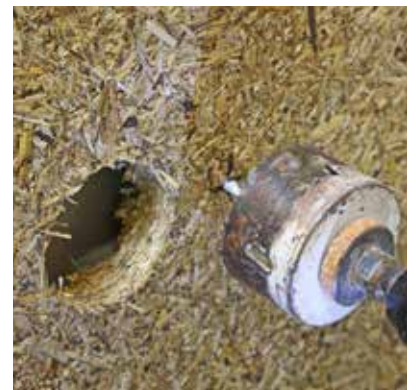
Einschneiden der Öffnung mit Bohrkronen
