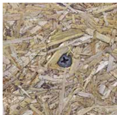
Oberflächenbündig gesetzte Schraube
