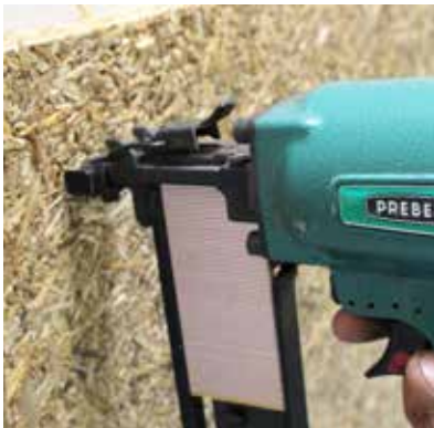
Befestigen mit Breitrückenklammern mit Setzgerät
