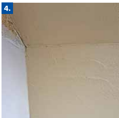
4. Putz auftragen (3 bis 4 mm bzw. 8 bis 10 mm) und abziehen
