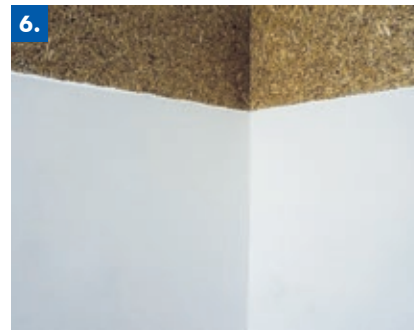
6. Oberfläche mit Kalkglätte abgespachtelt
