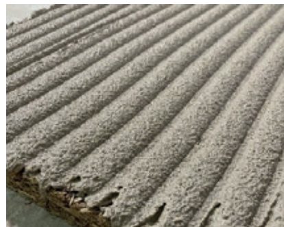
Kleberauftrag Platte
