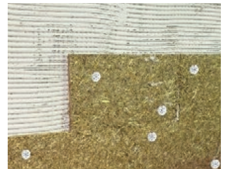
Verdübelung der Platten bei nicht tragfähigen Untergründen
