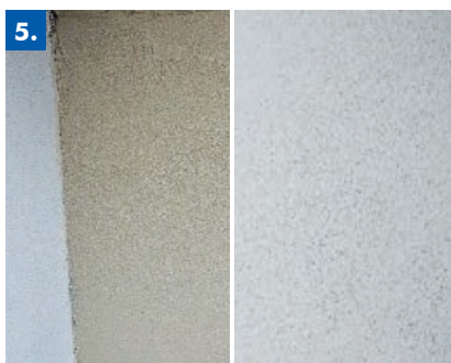
5. Putz auftragen 3 bis 4 bzw. 8 bis 10 mm und abziehen | Oberfläche fertig gefilzt
