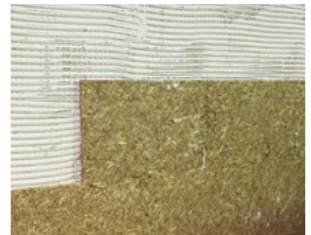
Verlegung im Verband
