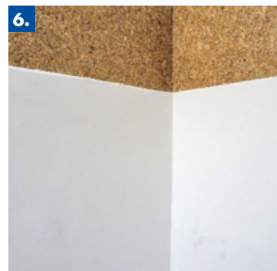
6. Oberfläche mit Kalkglätte abgespachtelt
