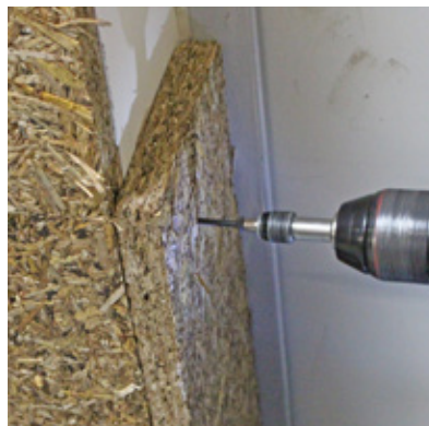
Befestigen mit Flachkopfschrauben
