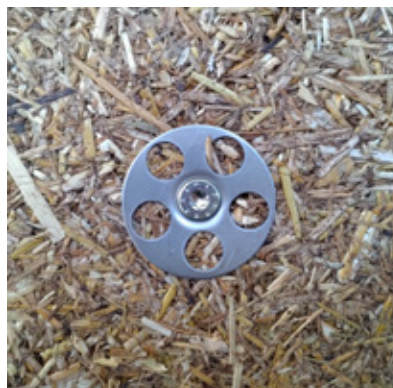
Deckenbefestigung mit einer für den Untergrund geeigneten Senkkopfschraube und Dübelteller
