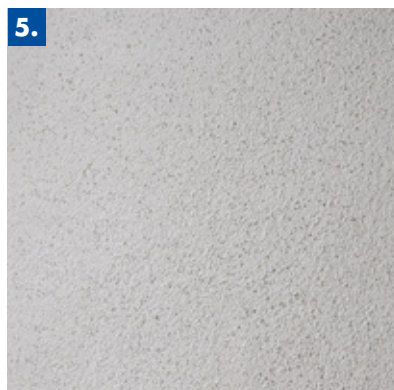
5. Oberfläche fertig gefilzt
