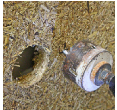
Einschneiden der Öffnung mit Bohrkronen
