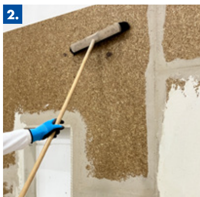
2. Oberfläche reinigen
