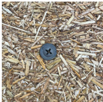
Oberflächenbündig gesetzte Schraube
