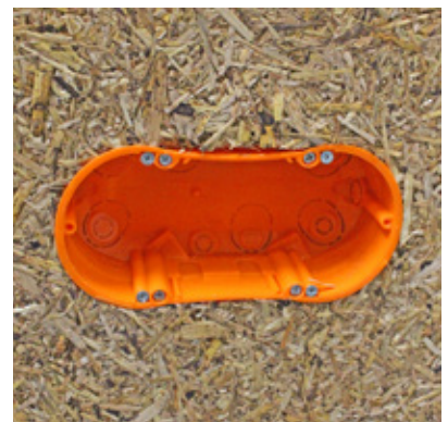
Passgenau eingesetzte Hohlraumdose
