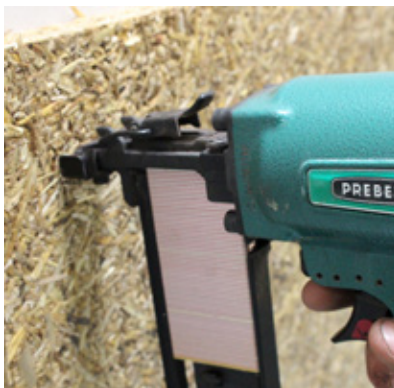
Befestigen mit Breitrückenklammern mit Setzgerät
